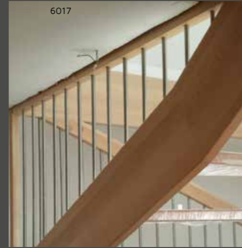
Geländer mit Deckenanschluss
