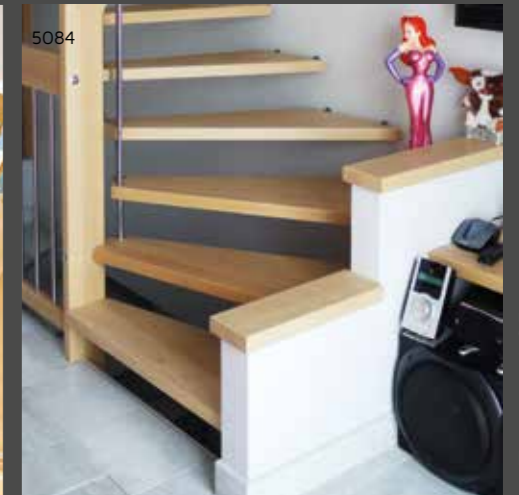
Abdeckbrett auf Brüstungswand
