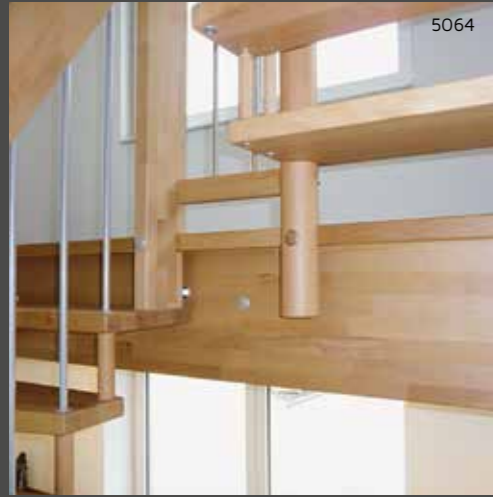
Durchgehende Deckenkantenverkleidung
